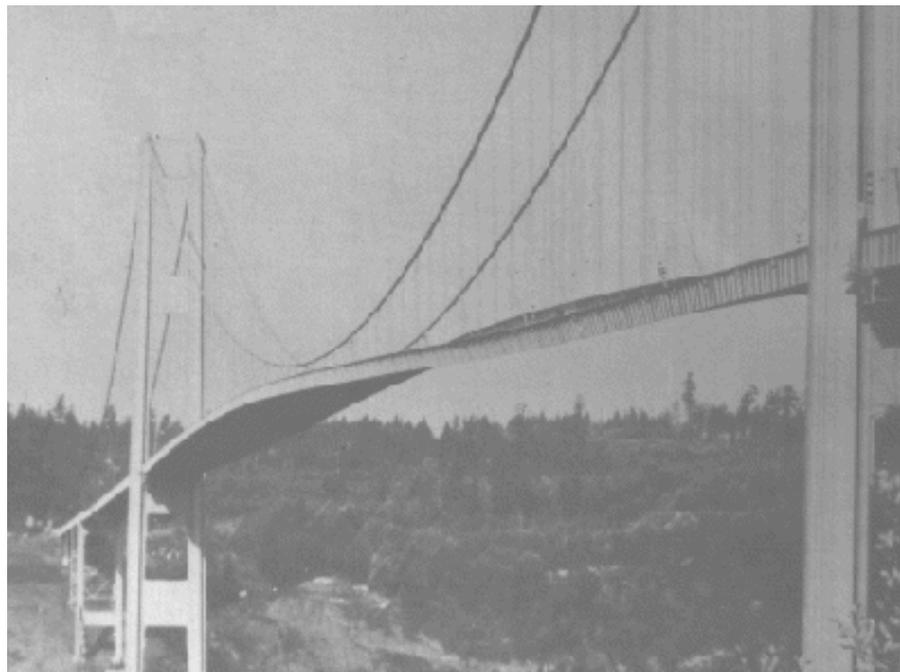
FIG. 10 – Photographie de l'instabilité qui a conduit à la destruction du pont de Tacoma le 7 Novembre 1940.
